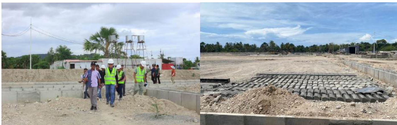
Legenda: A equipa técnica do MESCC, a Agência de Desenvolvimento Nacional (ADN) e o Ministério das Obras Públicas (MOP), realizaram testes aos maciços de encabeçamento de estacas (PILE CAP) no projeto do novo edifício do IPB-Betano. (Março de 2024)
